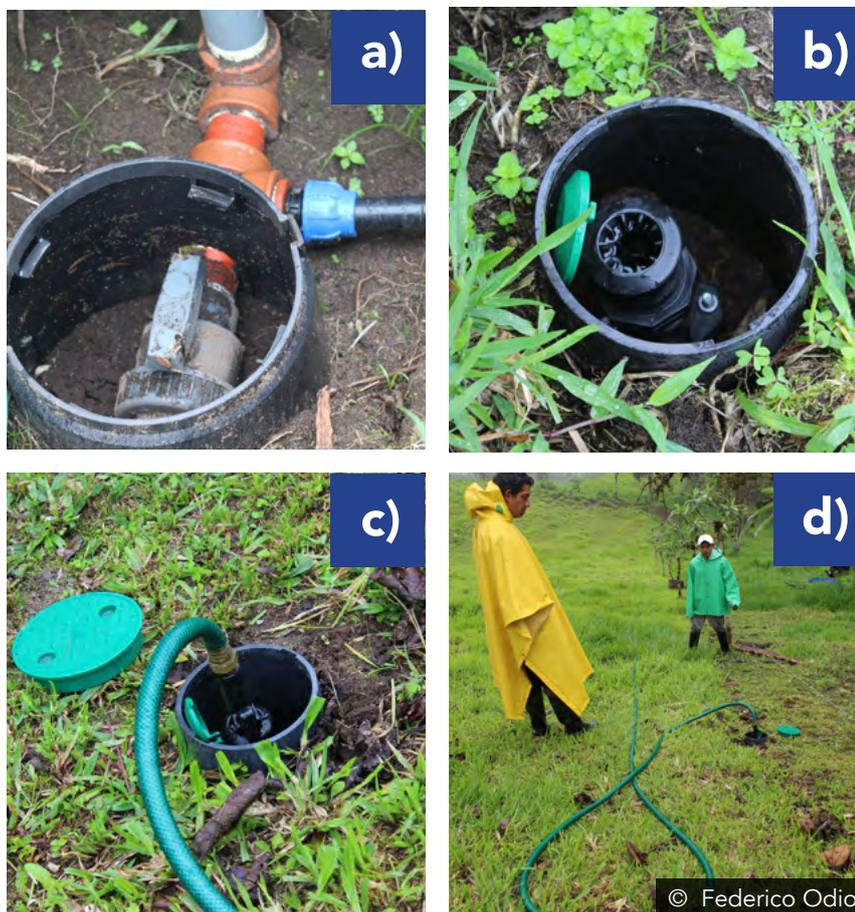
a) Llave de paso; b) hidrante de toma rápida; c) hidrante de toma rápida funcionando; d) ubicación de la toma de agua (hidrante) en el límite entre un potrero y el próximo.
