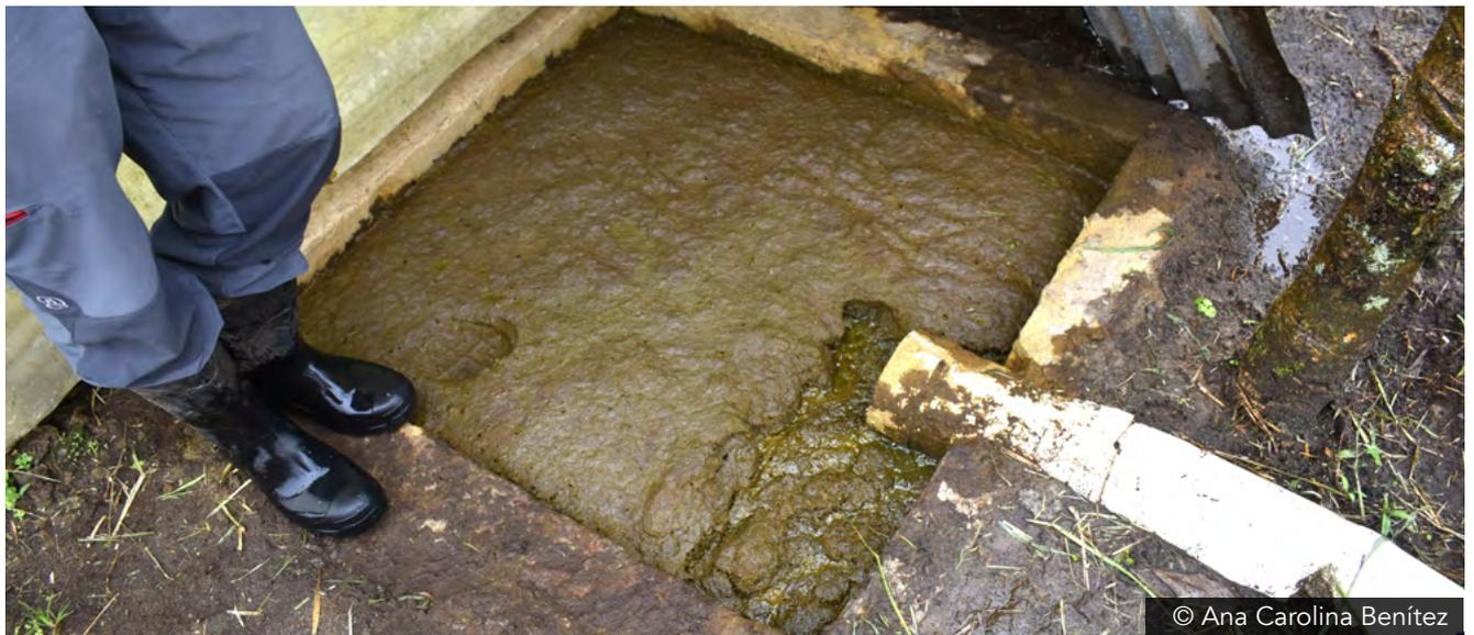
Por gravedad, el estiércol diluido se direcciona al tercer tanque, ubicado a la entrada del biodigestor (ver Figura 34). La mezcla va entrando al biodigestor a medida que se libera espacio.
