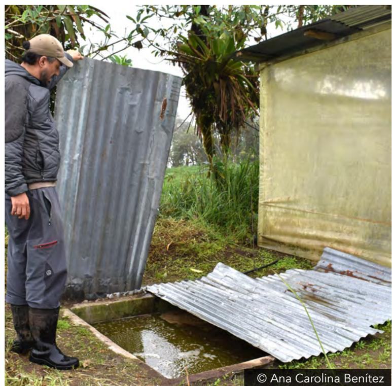
*El biodigestor de flujo continuo no requiere de mucho esfuerzo para su mantenimiento, sin embargo, cada año se debe descargar la totalidad del contenido para sacar el sedimento acumulado (biosol que también puede ser usado como abono) e iniciar el proceso de llenado nuevamente.*
