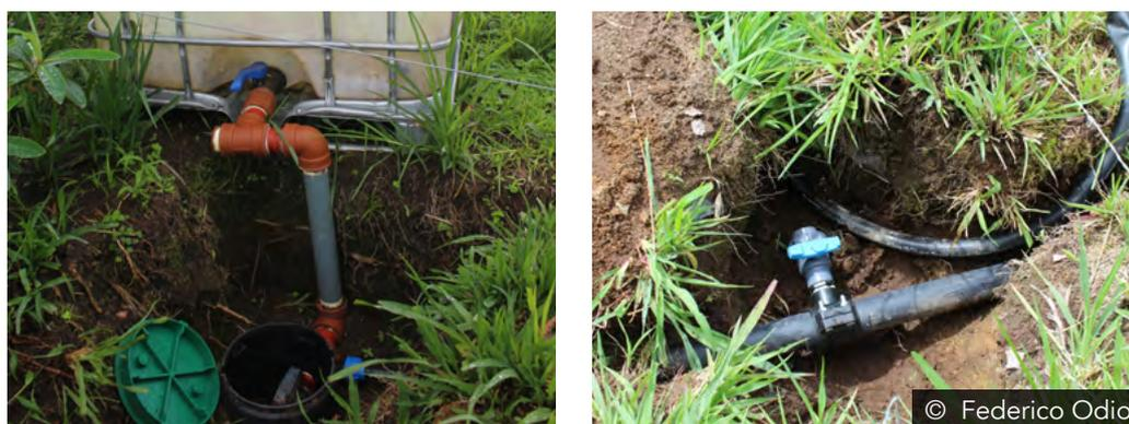
Es fundamental que todas las tuberías de la red de distribución vayan enterradas para protegerlas del sol y del pisoteo del ganado. Se recomienda que toda la red de distribución sea colocada en los límites de las divisiones de los potreros e infraestructura, en general, por debajo del alambre y cercas electrificadas para prevenir de mejor manera los daños.
