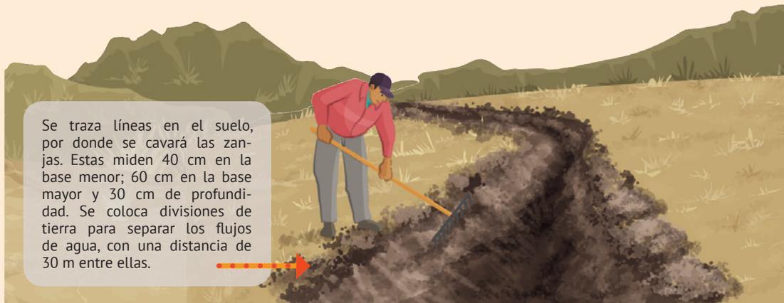
Se traza líneas en el suelo, por donde se cavará las zanjas. Estas miden 40 cm en la base menor; 60 cm en la base mayor y 30 cm de profundidad. Se coloca divisiones de tierra para separar los flujos de agua, con una distancia de 30 m entre ellas.
