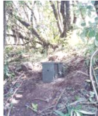
Figura 3. Vertedero de cresta delgada y caseta para protección del sensor de nivel
